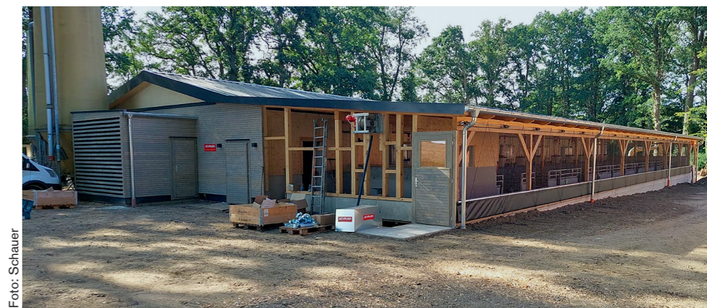
△ Der 400 Mastplätze Betrieb Lampe in Niedersachsen wurde zum Tierwohlstall umgebaut, das Altgebäude wurde um einen Außenklimabereich sowie eine Kot-Harn-Trennung erweitert.
